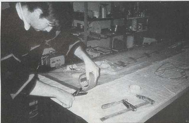
**M** ettre en place la valve, les ficelles ou les tissus complémentaires pour canaliser le vide. Fermer l'extrémité de la poche avec un scotch ou avec un appareil à souder les poches.
